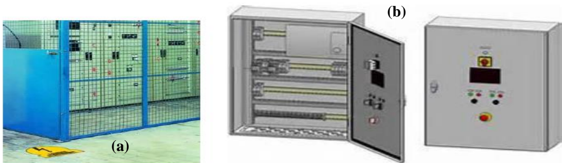
Figure III.14 : Protections permanentes par Grillage (a) et porte (b) d'armoire électrique
