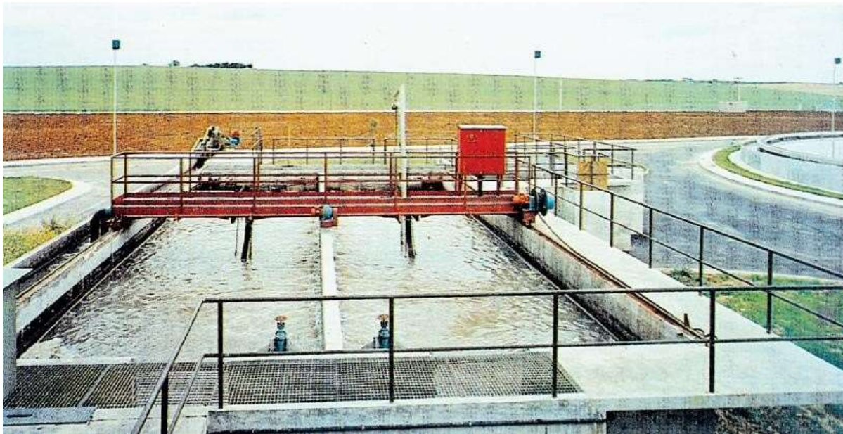
Figure II.5 : Bassin de déshuilage et dessalage
