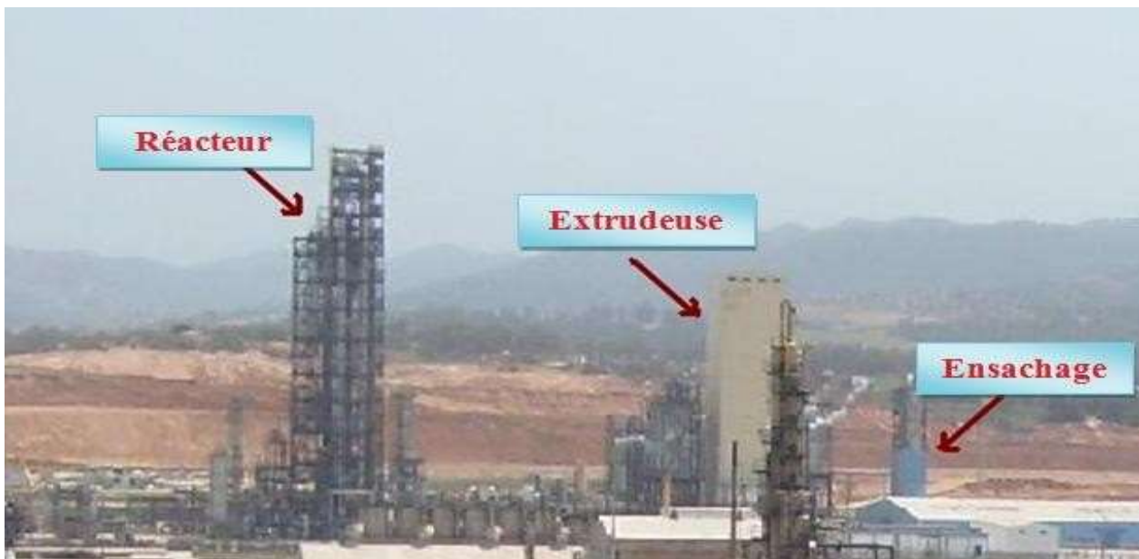
Figure III.3 : Photo représentatif des principales installations de l'unité CP2K.
