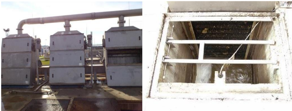
Figure II.2 : Poste de dégrillage [21].
