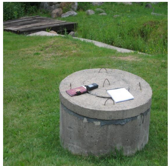
Puits de surface
