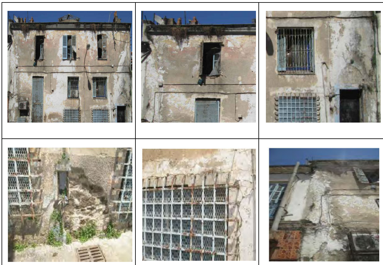
Levé des pathologie au niveau du façade Principale
