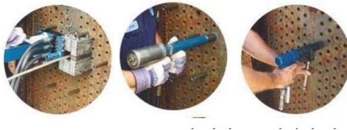
Figure III.3 : Nettoyage à l'aide d'un pistolet
