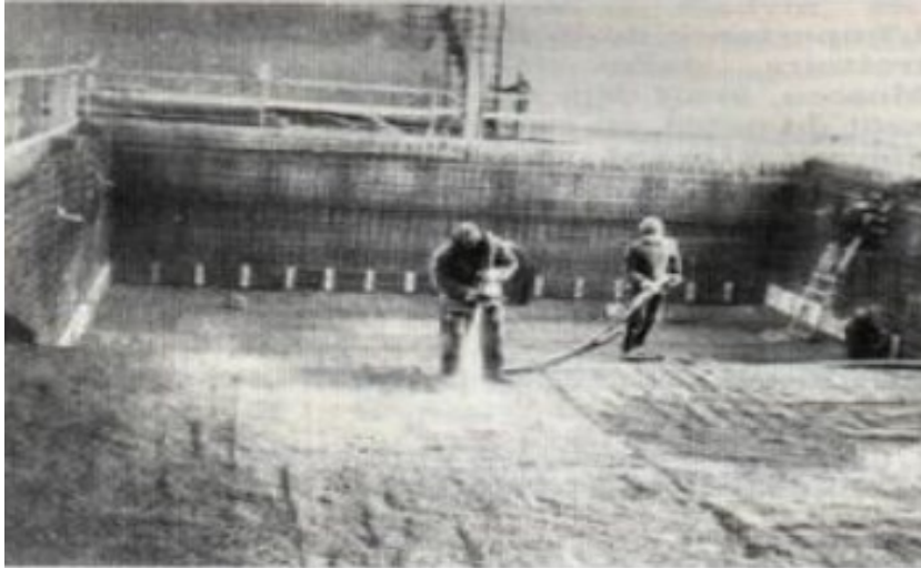
Figure I-9: Béton de sable coulé sur site (réalisation d'une piscine). (Bederina 2000)
