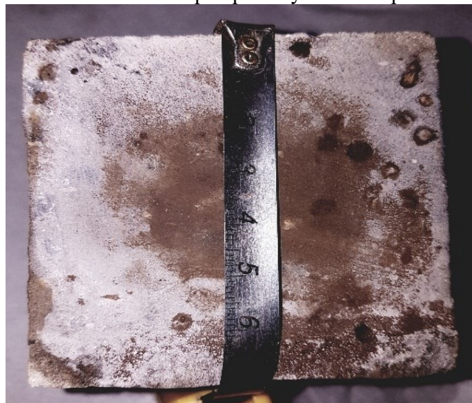
Figure III-19: Mesure de la profondeur de pénétration des chlorures
