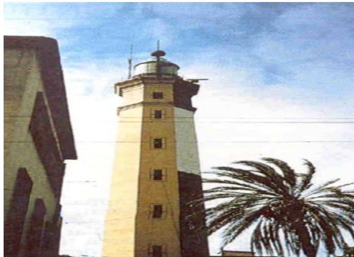
Figure I-1: Phare de port Saïd réalisé en béton aggloméré Coignet (Egypte). ( Sablocrete 1994 )
