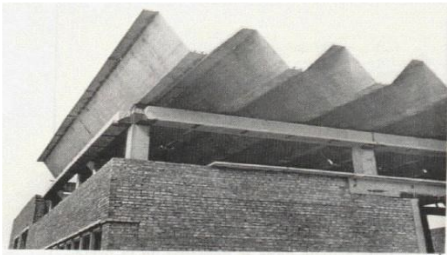
Figure I-8: Béton de sable dans la préfabrication. (Bederina 2000)
