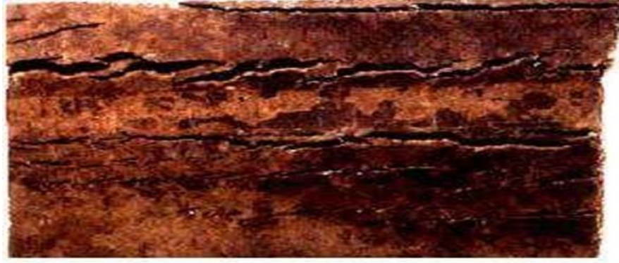
Figure I.8 : corrosion sous contrainte.
