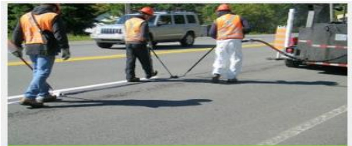
Fig.II.6. Scellement de fissures
