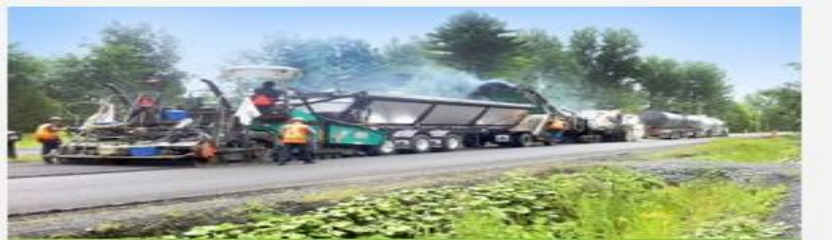
Fig.II.5. Retraitement de type I- recyclage à froid
