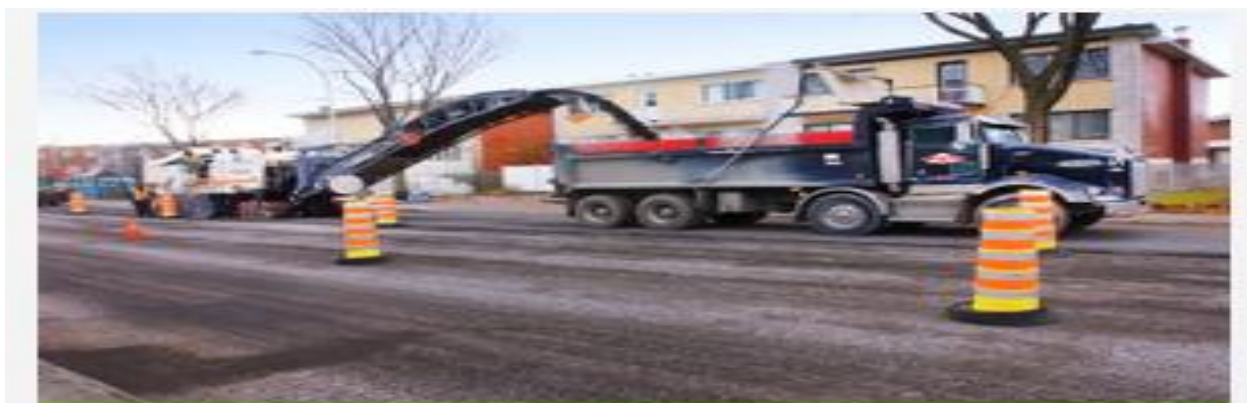
Fig.II.4. Planage et couche d'usure
