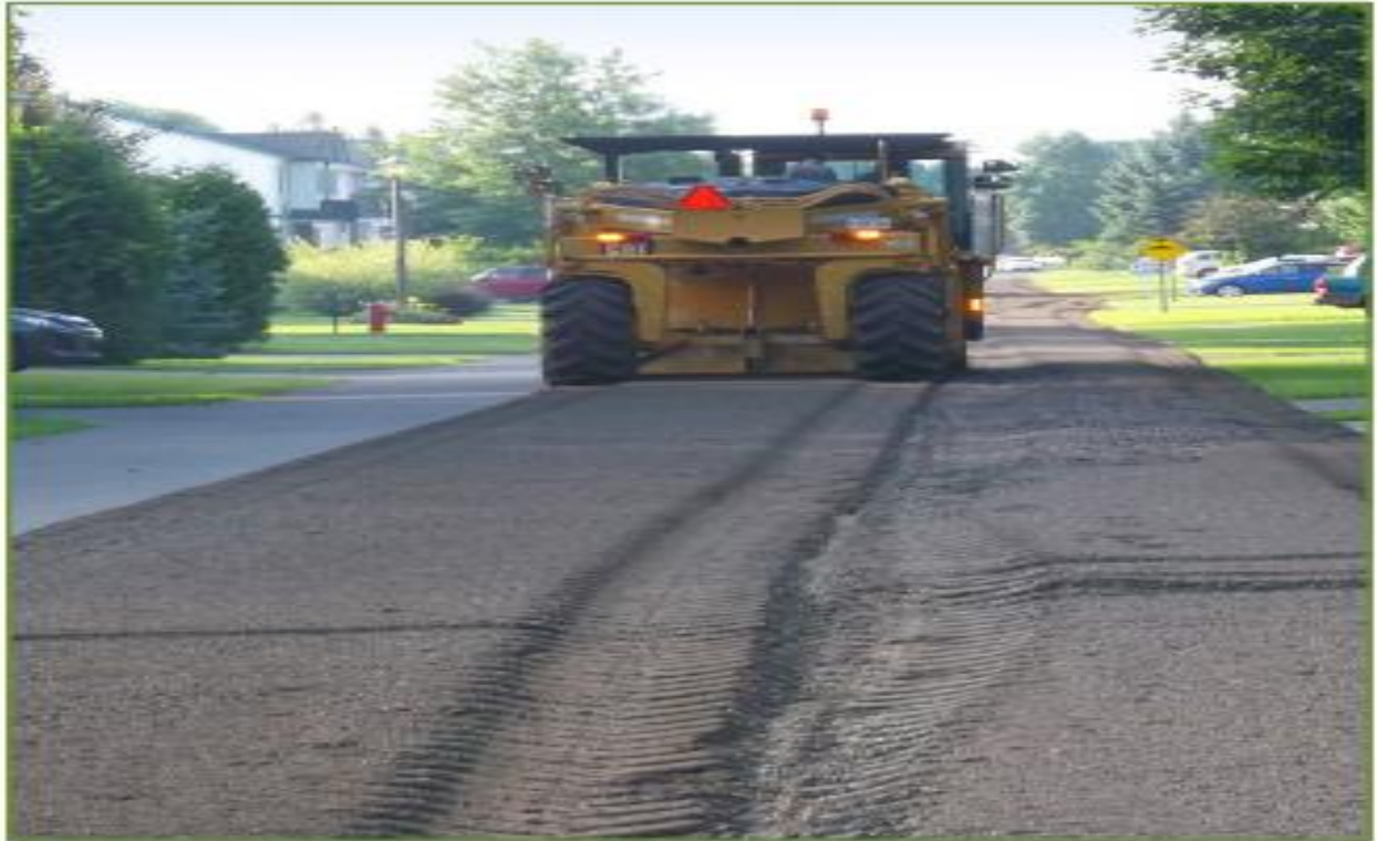
Fig.II.2. chaussée décohésionnée.
