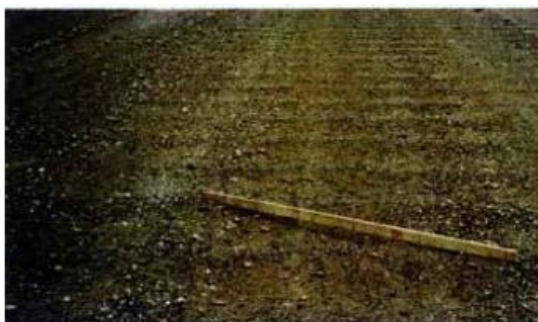
Fig. I.7 : Tôle ondulée
