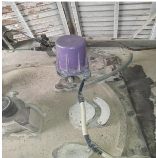
Fig. I.17 : détecteur de flamme.
