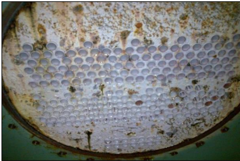
Figure II.4 : l'encrassement tubulaire.[20]
