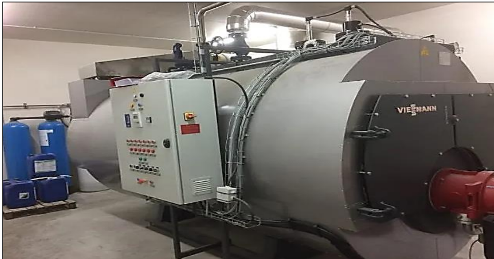
Fig.I.10 : Chaudière à tubes de fumées.[8]
