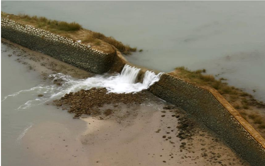
Figure I.5. Inondations par rupture d'ouvrage ou d'embâcle.
