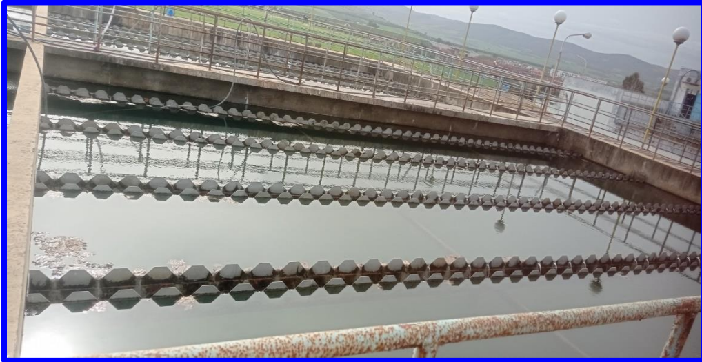
Figure II.8. Le décanteur tubulaire.
