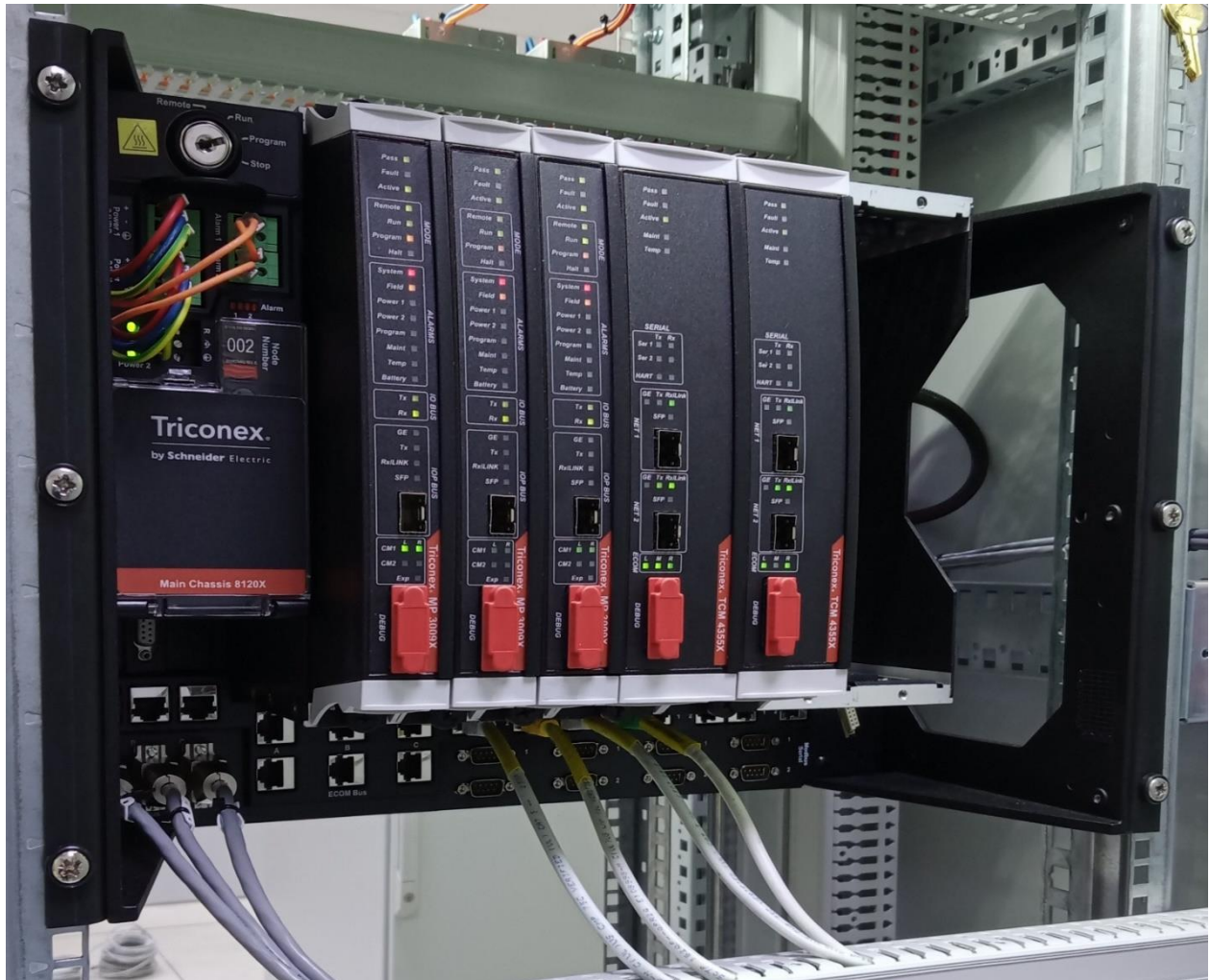
Figure III.1: Les principaux éléments du TRICON CX [6].
