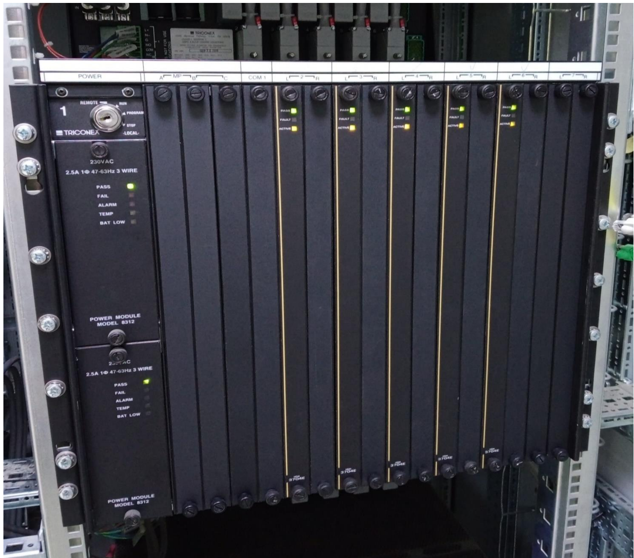
Figure III.9: Le châssis d'extension du TRICON CX.
