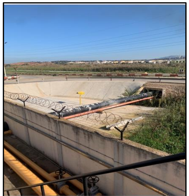
Figure 4 : Canal de rejet des eaux traitées vers la mer
