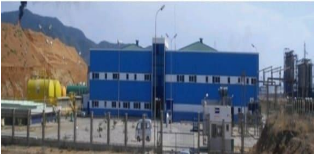
Figure (5). Présentation de la station de dessalement déssaladora _ Skikda
