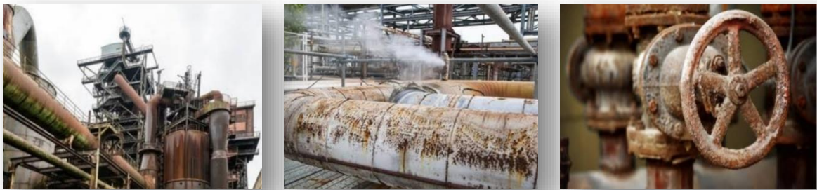
Figure I.16: des photos présentent la corrosion dans l'industrie
