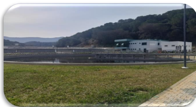
Figure 3 : la station d'épuration de la commun de filfila
