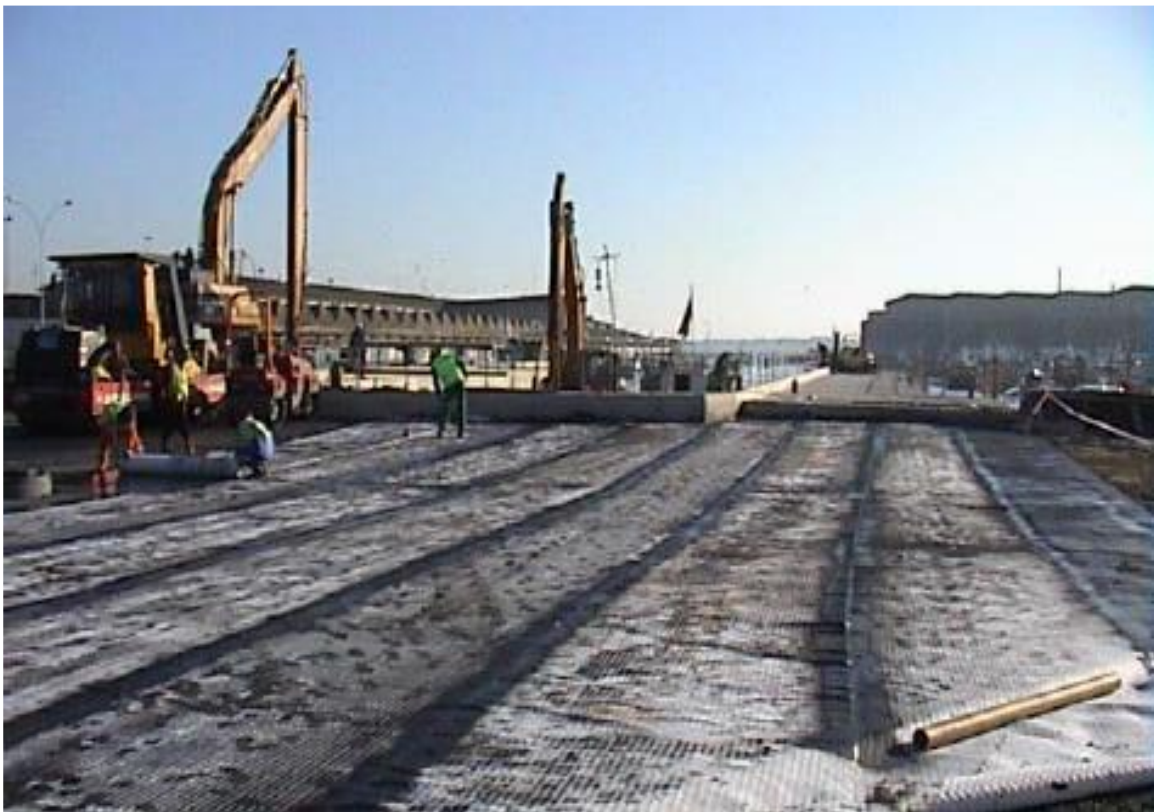
Figure III.9 : Chantier de géo-grille au Port Lorient, décembre 2001[1].
