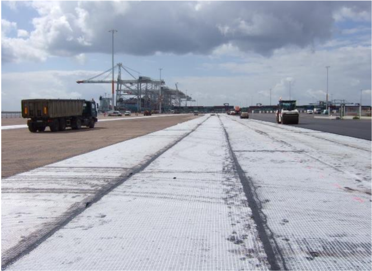
Figure III.10 : Renforcement d'une plateforme portuaire - Port Autonome du Havre [1].
