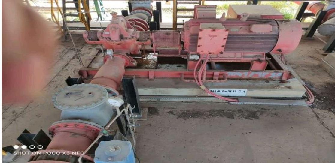
Figure III.9: pompes électriques.
