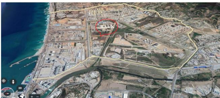
Figure I.2 : Situation géographique de la RA1/k dans la zone industrielle de Skikda.[3]
