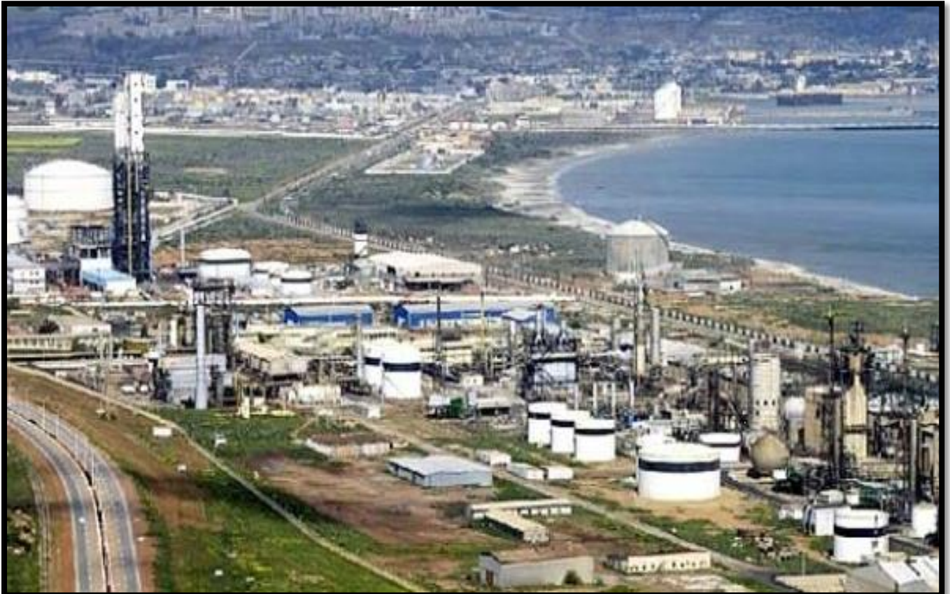
Figure 08 : Photo panoramique de la zone industrielle « SONATRACH » [2]
