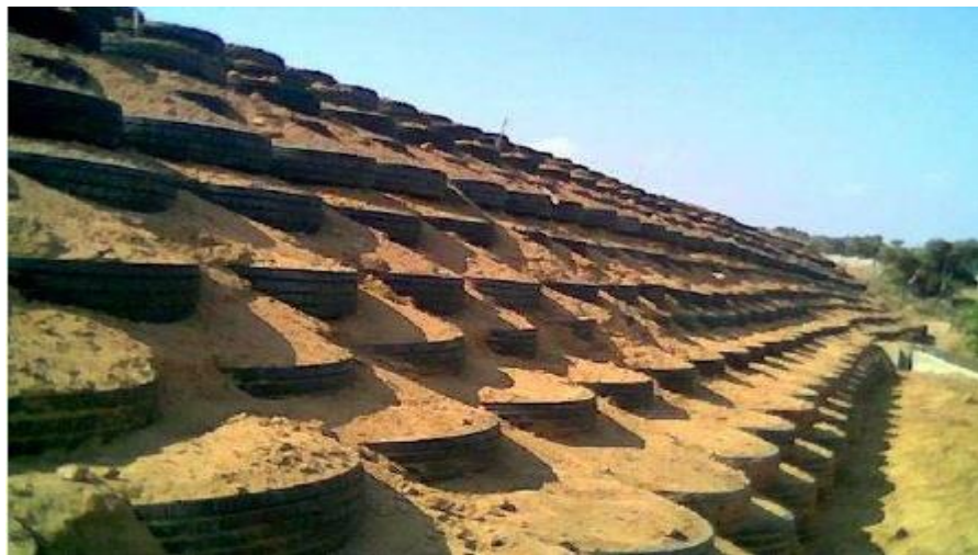
Figure II.10 Chantier expérimental Pneusol à Bou-Smail, , Meddah.A, (2015)
