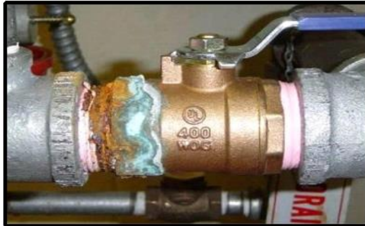
Figure I.5 : La corrosion galvanique d'un tuyau galvanisée.
