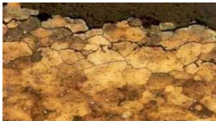
Figure 24 : Corrosion sous contrainte d'un alliage cuivreux
