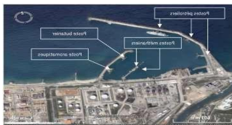
Figure 12: Photographie satellitaire montrant les infrastructures du nouveau port de Skikda (Google earth).
