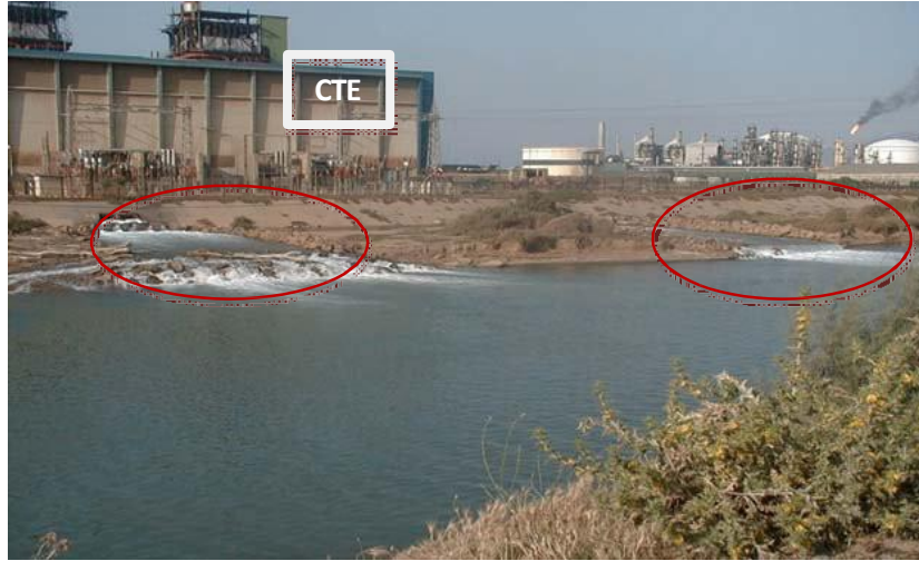
Figure 18: Photographie montrant 2 points de rejet de la CTE de Skikda (cercles rouges) dans les eaux de l'oued Safsaf (GUEDDAH, 2015).
