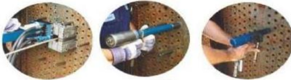
Figure II.5 : Nettoyage à l'aide d'un pistolet hydraulique [26]
