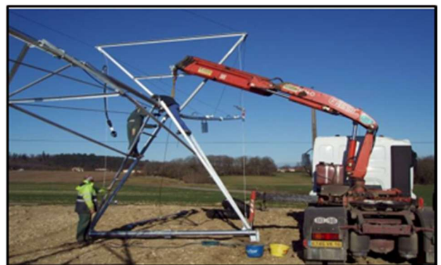
Figure VI.6: Le montage du pivot central
