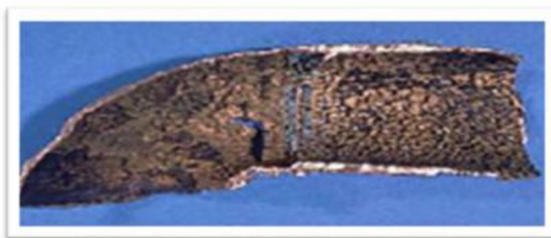
Figure I.7 : Corrosion érosion d'un tube en cuivre véhiculant de l'eau [12].
