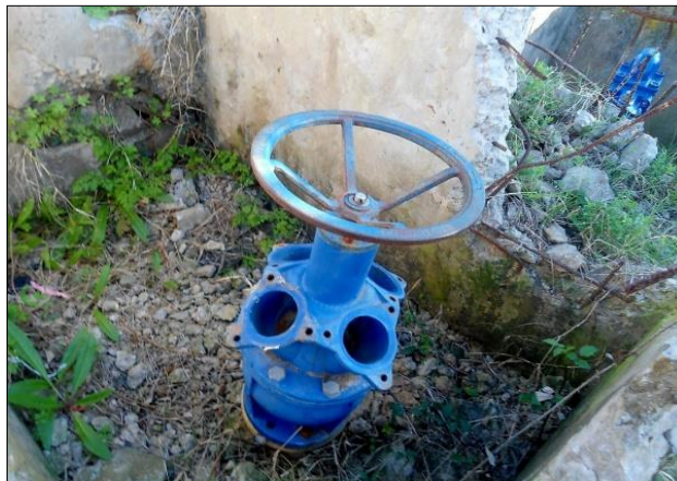
Figure III.3. Borne d'irrigation du réseau
