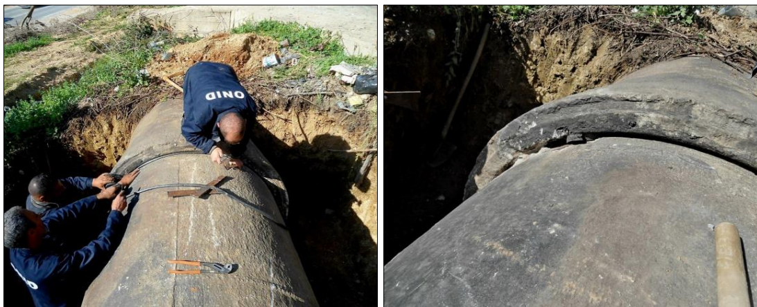
Figure III.4. Fuite détectée au niveau d'adduction Guénitra en 2020 (ONID, 2025)
