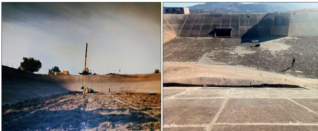
Figure III.10. Problème d'envaseement des réservoirs (le Réservoir N°3 de secteur d'EL Harrouch) (ONID, 2025)
