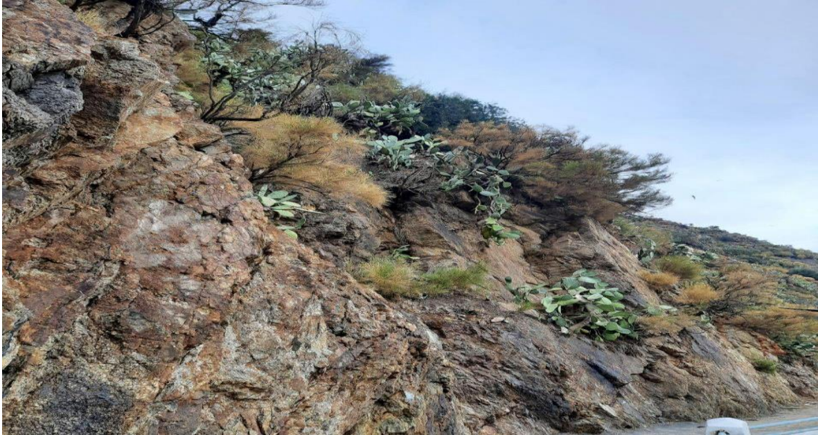
Photo 03 : Traces d'incendie dans les falaises de Stora, (photo personnel, 27/02/2023)
