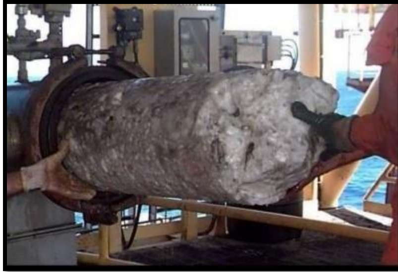
Figure III.11 : Blocages d'hydrates de gaz formés dans un pipeline d'hydrocarbures sous-marin [73].
