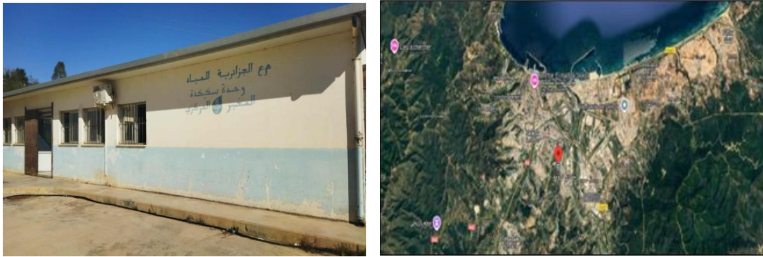
Figure 03 : Situation géographique Laboratoire Centrale ADE Skikda
