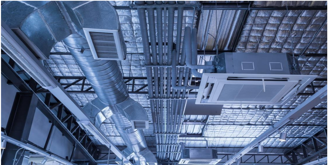
Figure 2.1 : installation système HVAC.
