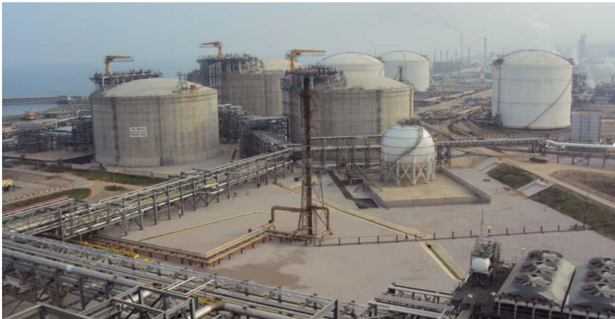
Figure II.3 : Photo réel des nouveaux bacs des stockages
