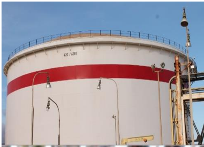
Fig.13 Bac à eau anti-incendie -Complexe Arzew- SONATRACH
