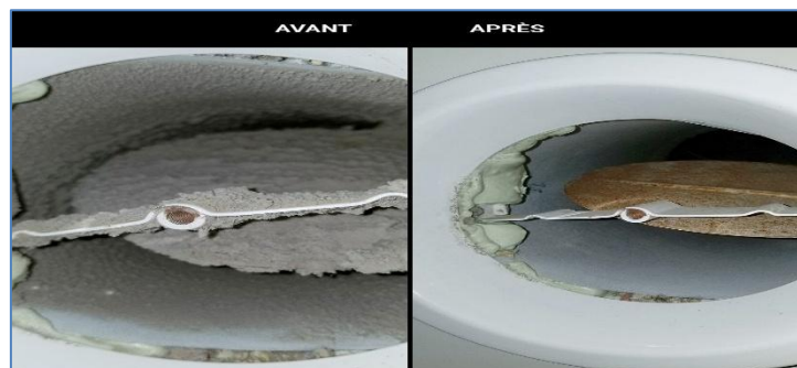
Figures II.12: Nettoyage des conduites par projectile – comparaison avant/après[64]
