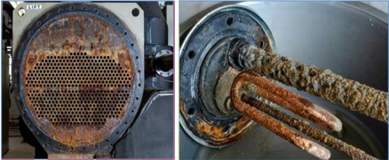
Figures II.2 : Accumulation de dépôts sur une surface d'échange thermique (phénomène d'encrassement) [40]
