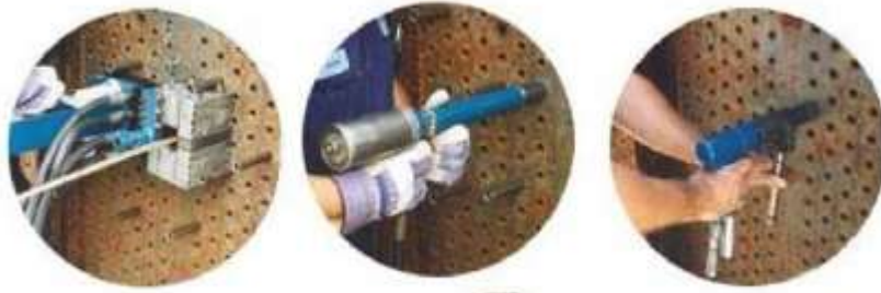
Figure II.5 : Nettoyage à l'aide d'un pistolet hydraulique [26]
