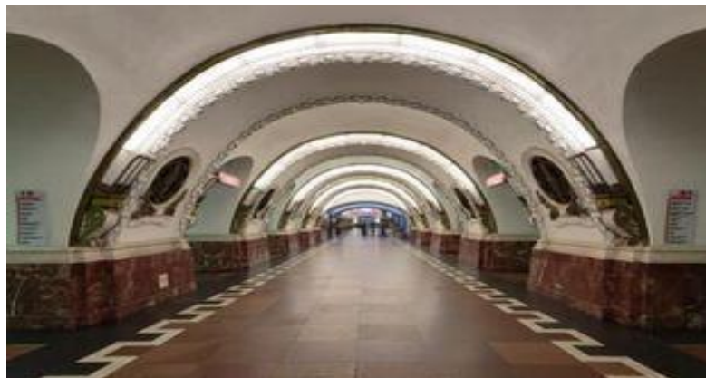
Fig.I.1 Métro de Saint Pétersbourg avec une voûte mince en béton de sable
