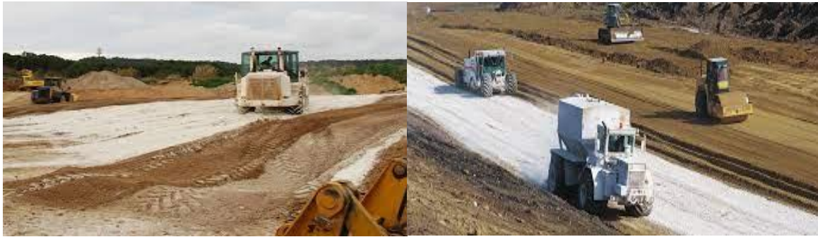
Figure 1.16 : Chantier de traitement d'un sol à la chaux
