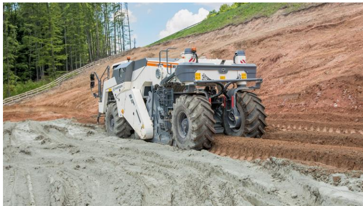
Figure 1.18 : Chantier de traitement du sol au ciment.
