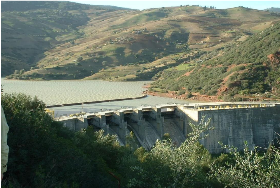
Fig20 : Barrage de Zérdazas (E Bourse DZ)
