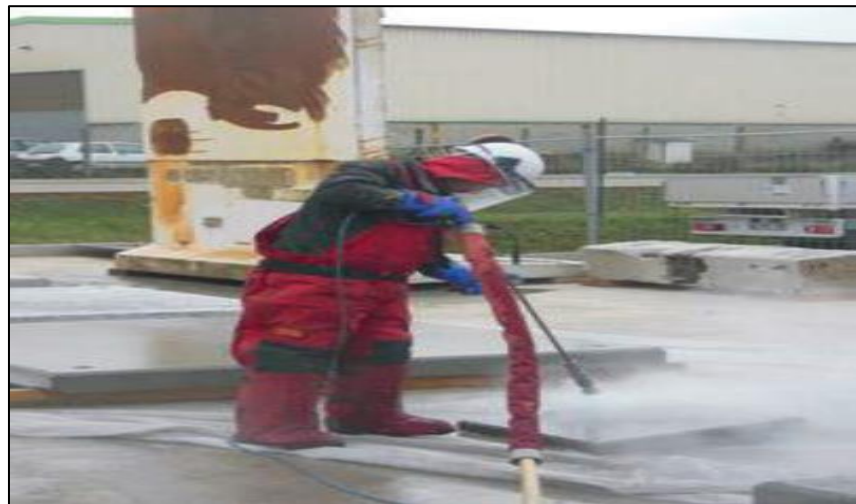
Figure II.18 : Décapage à l'eau sous pression UHP [29].
