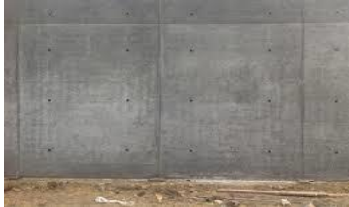
Figure I.4 : Support en béton.
