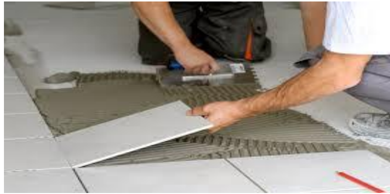
Figure I.1 : Fixation du carrelage par le mortier colle.
