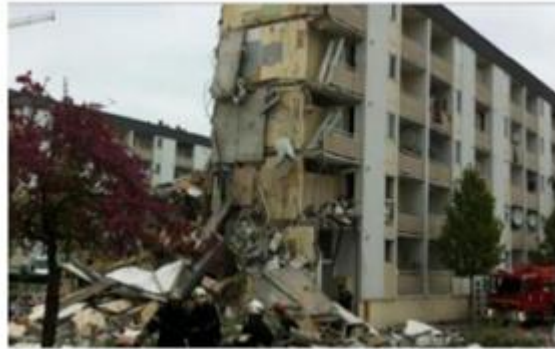
Figure 1. 9 :la surveillance des bâtiments avec les RCSF
