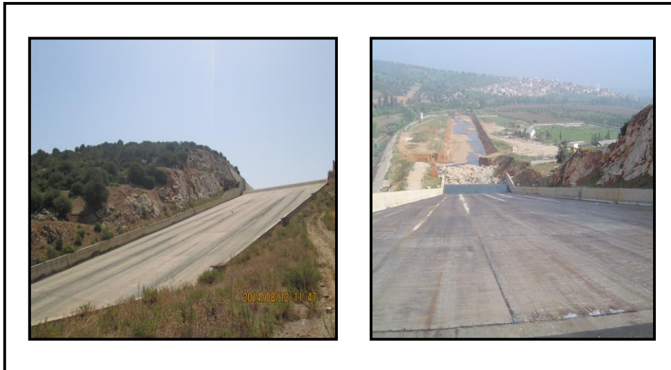
Figure 3.5. Evacuateur des crues de Zit Emba
