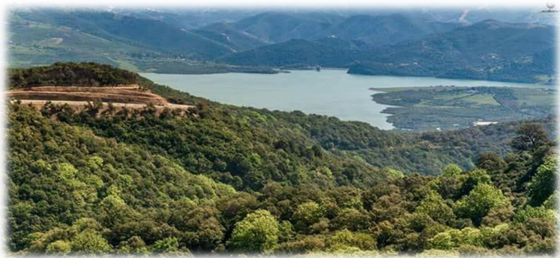
Fig. 23 : Photo du barrage Béni Zid.
