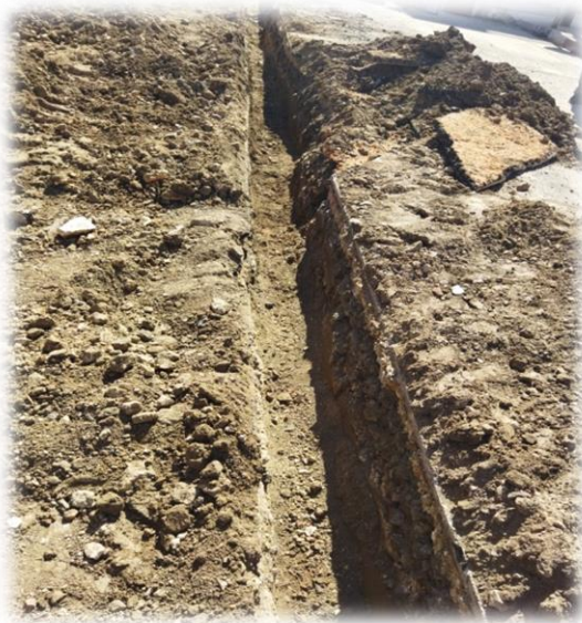
Fig.30 : Tranchée de creuser.(2023)
