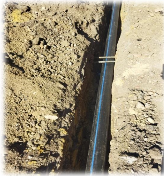
Fig.31 : Méthode de pose des tuyaux.(2023)
