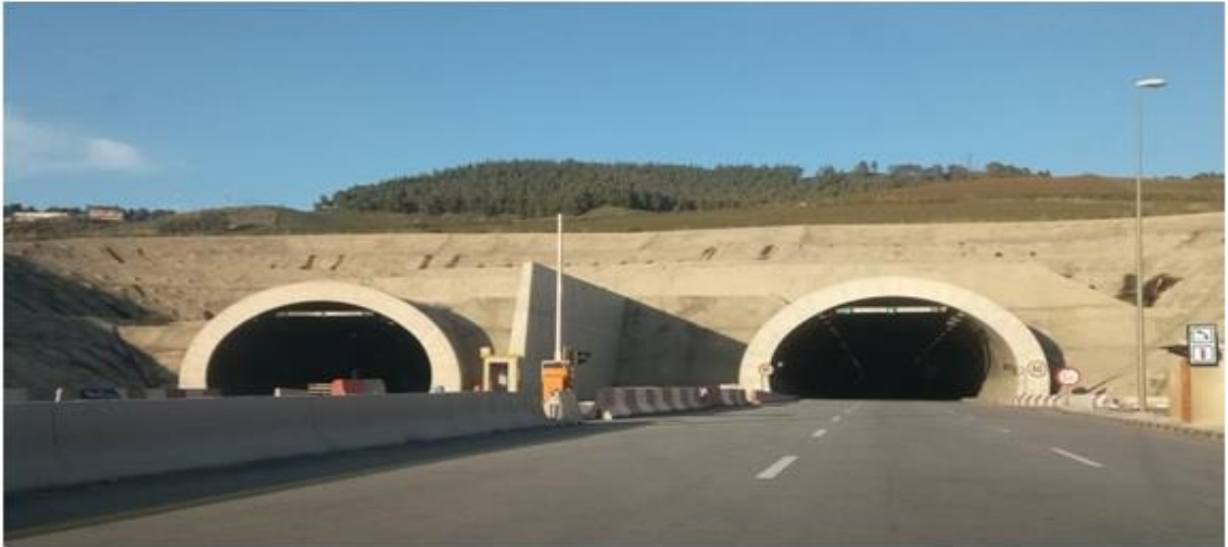
Figure 4.1. Vue générale de deux tubes du tunnel T4.
