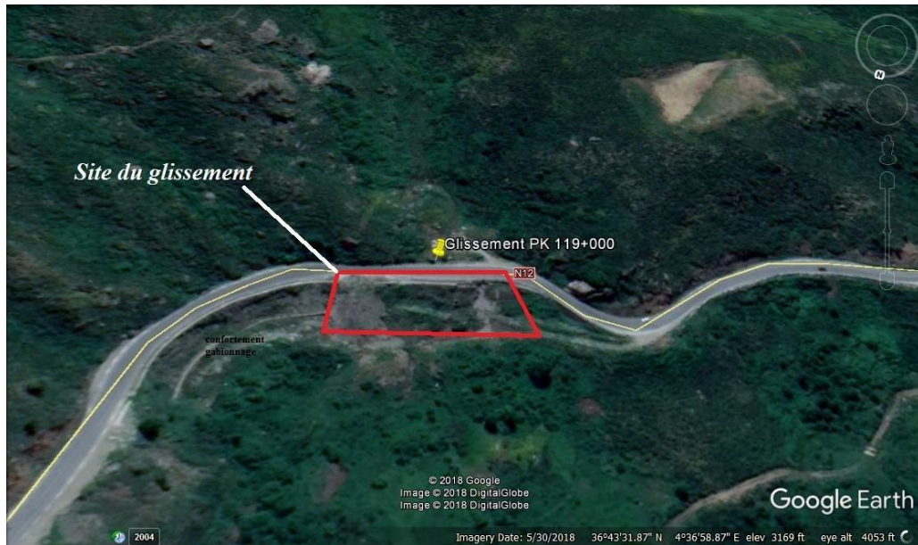
FIG IV.2 SITUATION DETAILLEE DU SITE DU GLISSEMENT
