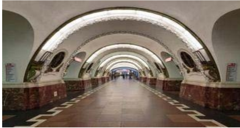
Fig.I.1 Métro de Saint Pétersbourg avec une voûte mince en béton de sable
