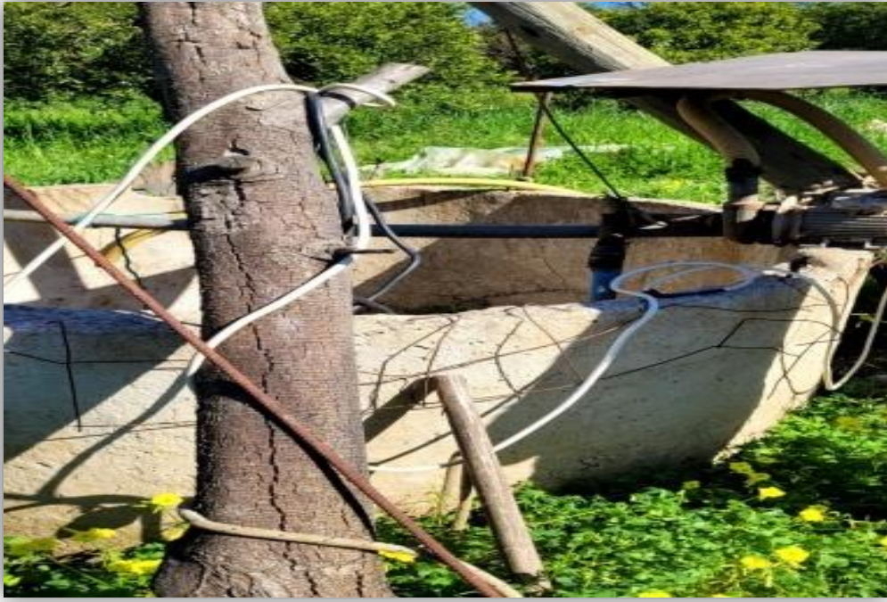
Photo N°2 Puit agricole (sortie 2024)
