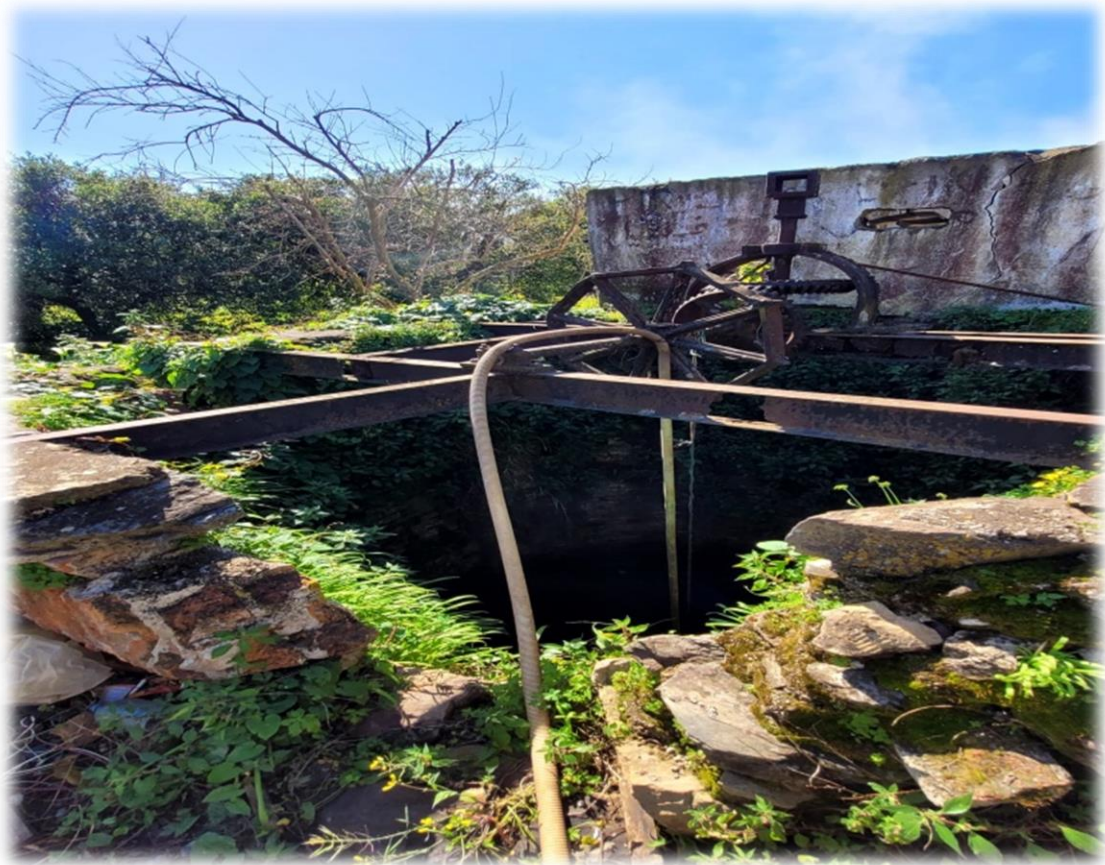
Photo N°5 Puit agricole (sortie 2024)
