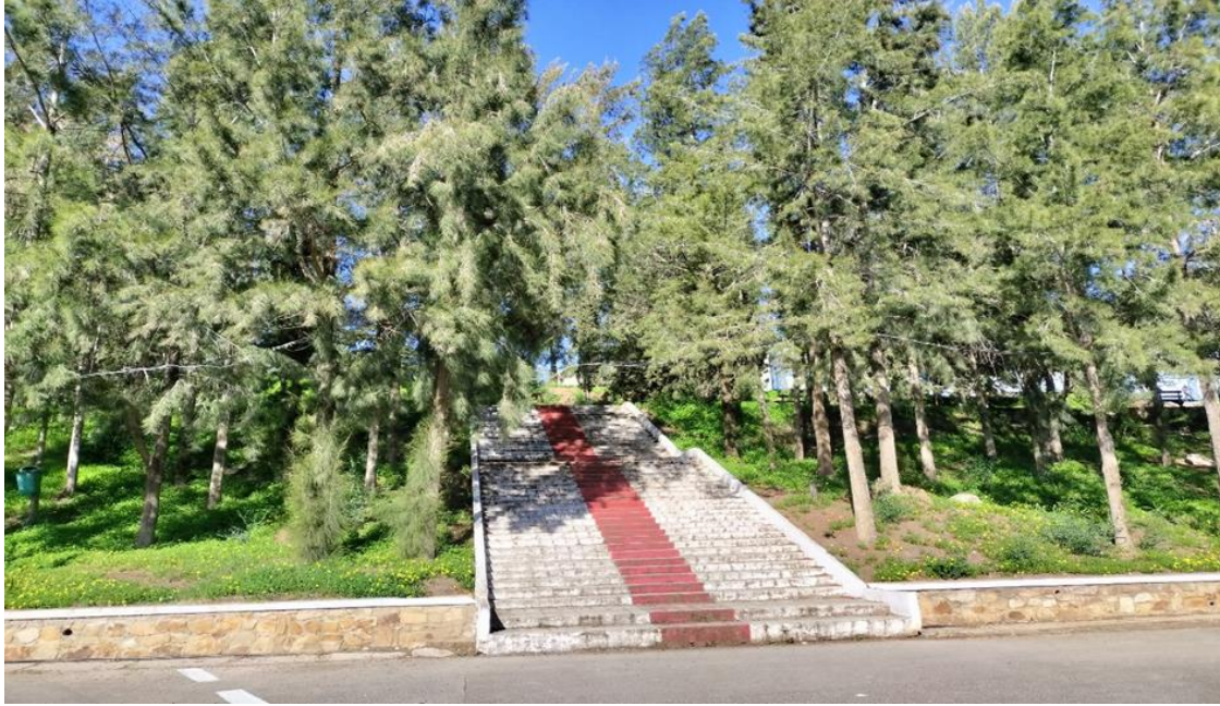
Figure 17 : Entrée Bloc laboratoires (08/02/2024)
